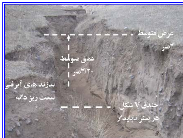
شکل ۳: خندقی V شکل در خاک‌های ریزدانه با ترکیبی از رسی و سیلتی شن و ماسه و قلوه‌سنگ مأخذ: نگارنده
